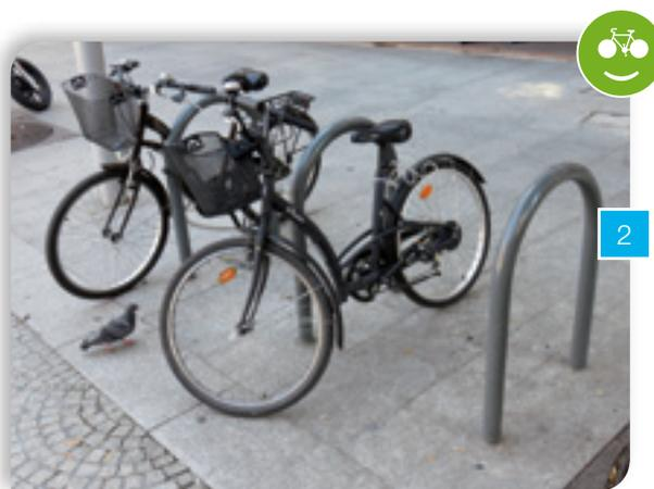
► [Photo 2](#) Les parkings à arceaux, de type " U " inversé ont la faveur des cyclistes. Le vélo est bien soutenu, et il est possible d'attacher le cadre, voire même les deux roues.
