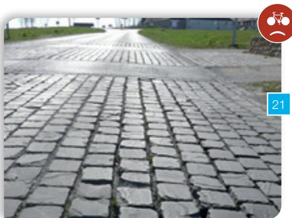
Localement, des revêtements en pavés ou en dalles sont utilisés par souci d'esthétique ; ils posent souvent des problèmes de glissements par temps de pluie et des contraintes d'entretien élevées (rejointement de pavés).
