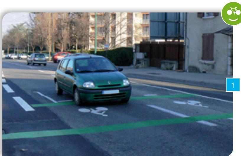
Le "Sas" permet au cycliste de sécuriser sa trajectoire vis à vis des automobilistes. Il lui permet d'être vu, d'anticiper et présélectionner son "TAG". Il peut ainsi "démarrer" au passage du feu au vert en position avancée par rapport à eux et avec une visibilité accrue.
